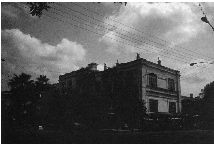
شهرداری قائم‌شهر (شاهی سابق): یگانه و تنها بودن بنا با چهارنمای مشخص نمونه‌ای از بناهای فراوان این دوره
